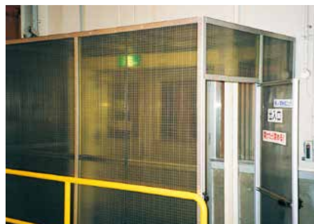
オプトロン前室ビニールブース
