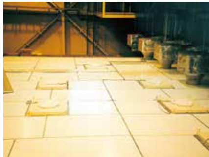
クリーンブース天井面
