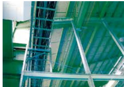
障害物間仕切り工事
